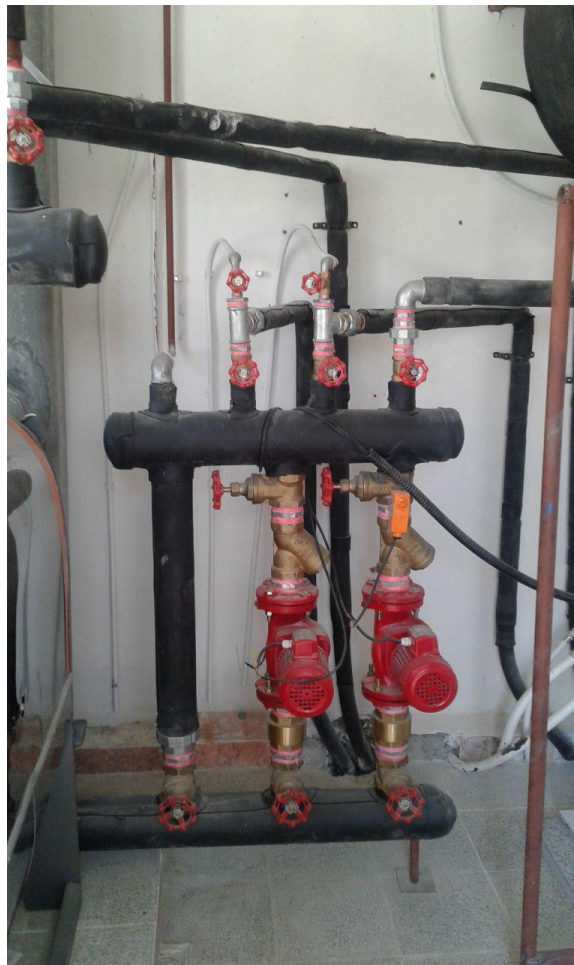
شکل ۷- عایق های الاستومری لوله های تاسیساتی
