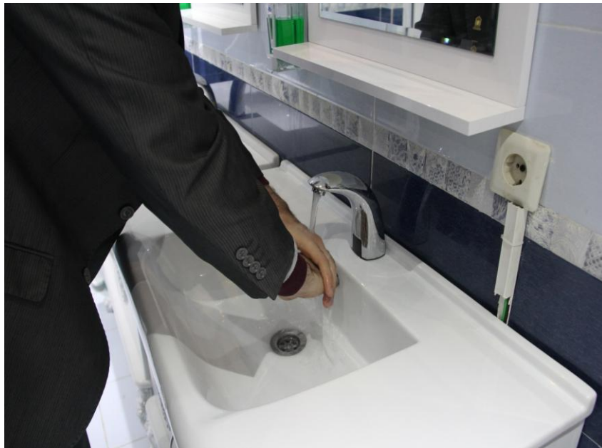
شکل ۱۰- استفاده از شیرآلات هوشمند در سرویسهای بهداشتی
